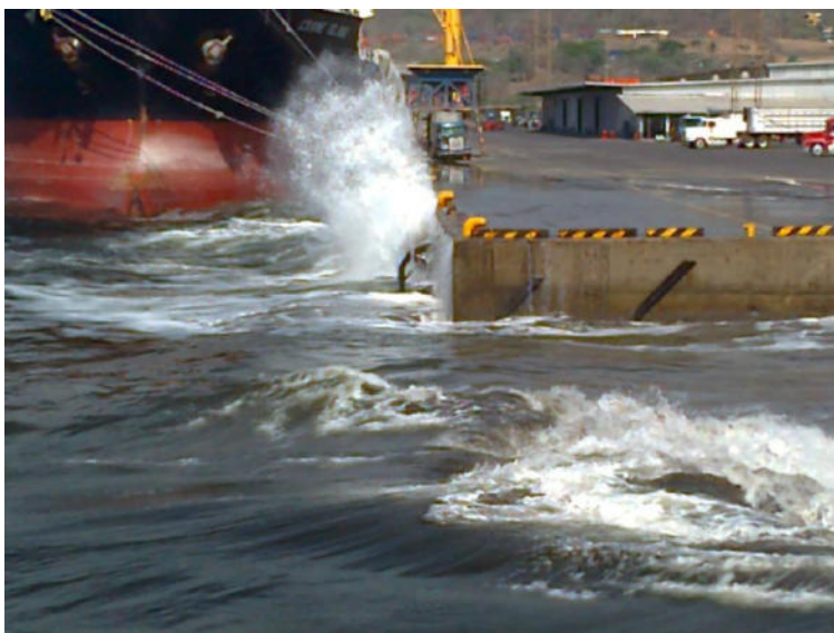
Figura 4-21 Rompimiento del oleaje frente al primer puesto de atraque por efecto de la poca profundidad debida a la sedimentación
